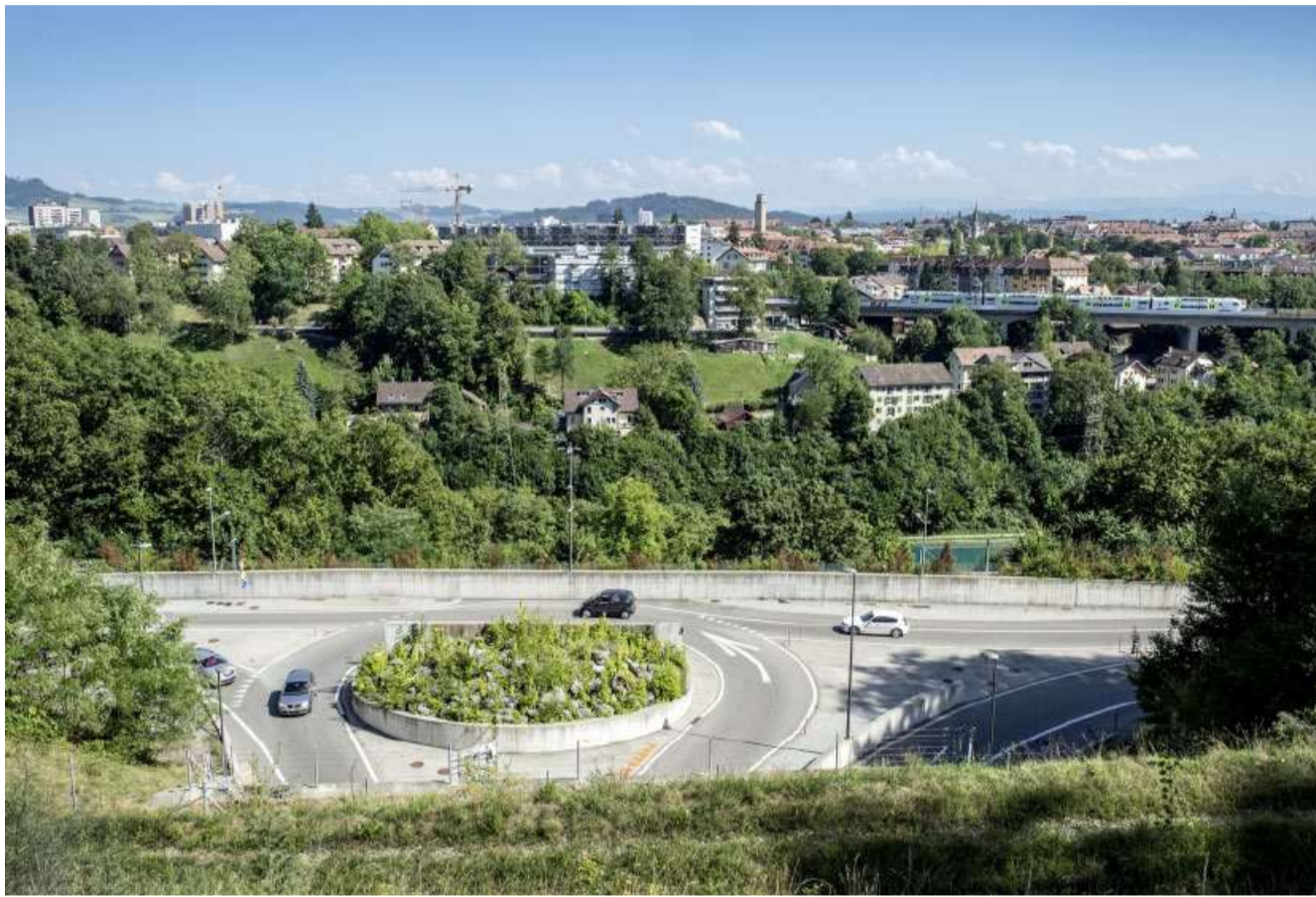
Von hüben nach drüben: Beim Portal des Berner Neufeldtunnels befände sich der westliche Brückenkopf. Foto: Adrian Moser (Archiv)
